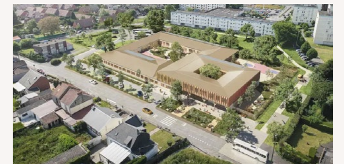
Figure 5 : Ecoles Claude Debussy et Anne Franck | Maubeuge (59) | BBC Effinergie 2017 | MO : Ville de Maubeuge | Avant-Propos Architecte
