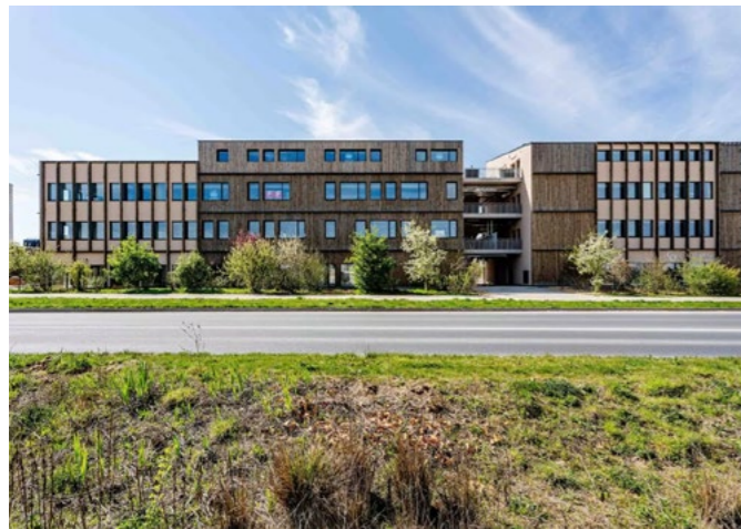
Figure 33 : Oxygène | Epron (14) | Bepos Effinergie 2017 | MO : Normandie Aménagement | Architecte : Meignan Engasser Peraud Architectes
