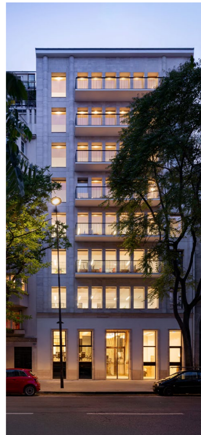
Figure 22 : Bureau 135 Wagram | Paris (75) | BBC Effinergie rénovation 2021 | MO : SARL 135 Wagram | Architecte : Ateliers Quinze Vingts
