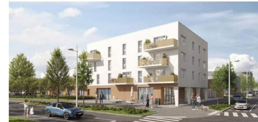
Figure 26 : Résidence Les Rochambelles | Epron (14) | Bepos Effinergie 2017 | MO : Caisse des Dépôts et Consignation
