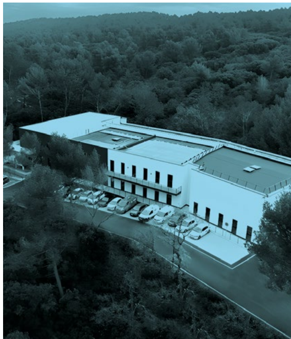
Les terrasses de Bachasson | BEPOS effinergie 2017 | Meyreuil (06) | MO : Groupe Artea | Agence VBI
