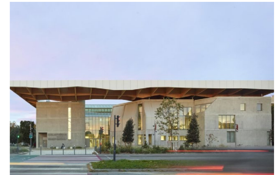
Figure 18 : Bibliothèque Jean Louis Barrault | Avignon (84) | BBC Effinergie Rénovation 2009 | Architecte : Architecte Jakob + MacFarlane | MO : Ville d'Avignon
