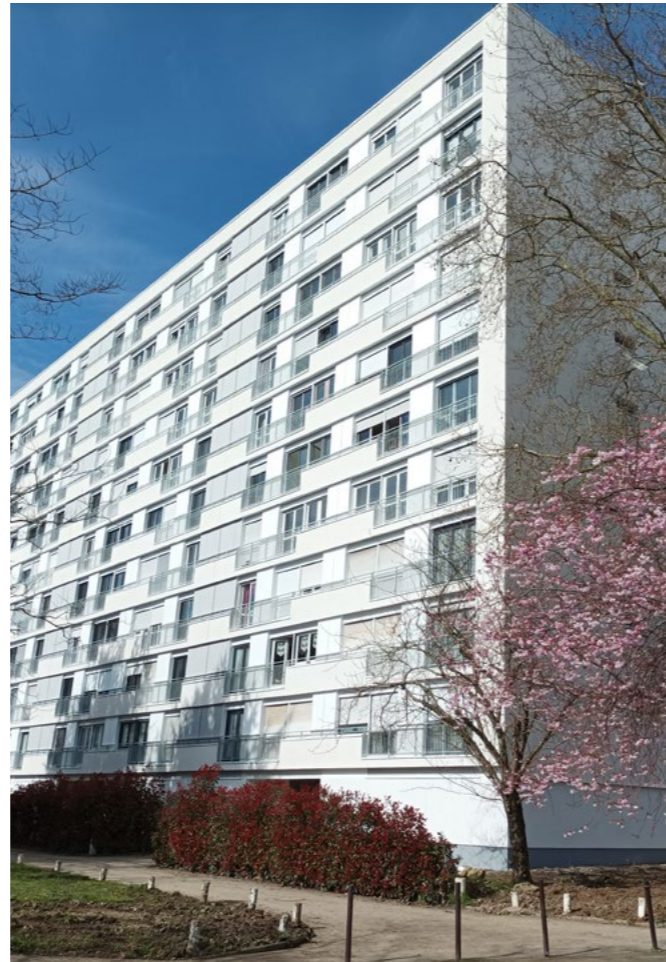
Figure 3 : Copropriété Beau Rivage II | Nantes (44) | BBC Effinergie Rénovation | MO : Citya Hôtel Dieu | Mervane Architectes
