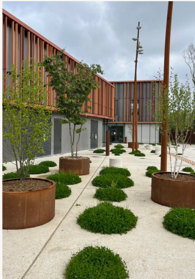
Figure 6 : Site de Maintenance et de Remise Tram10 | Chatenay Malabry (92) | BEPOS Effinergie 2013 | MO : Syndicat des Transports d'Ile de France | AIA Architectes
