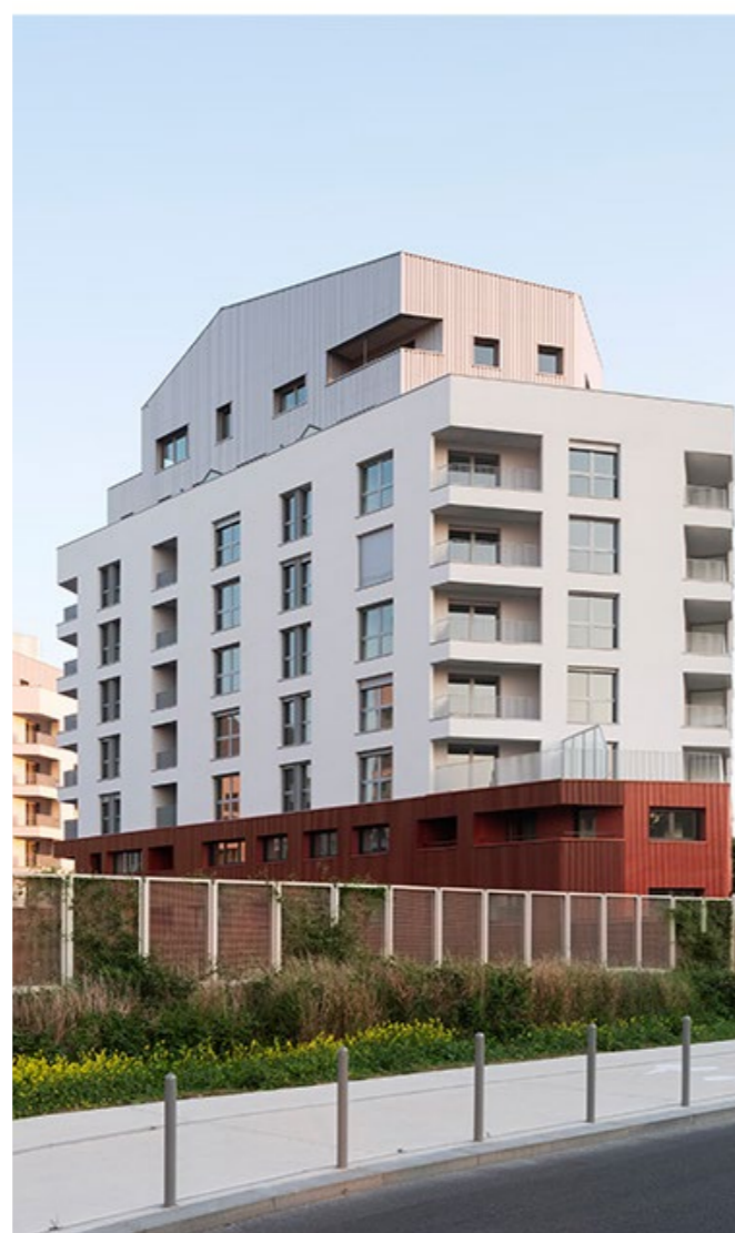
Figure 30 : Résidence Lot B1b | Champs sur Marne (77) | Bepos Effinergie 2017 | MO : Linkcity Ile de France | CoBe Architecture
